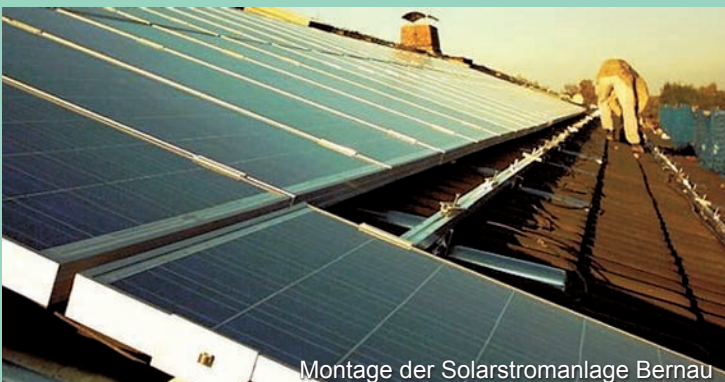
Montage der Solarstromanlage Bernau
