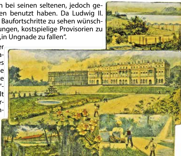
Kolorierter Stich der Schlossbaustelle um 1885 (KH)
