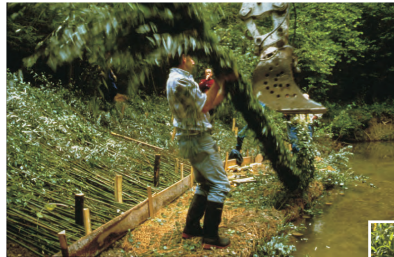
Ingenieurbiologische Arbeiten an Gewässern - "Berauherung" und "Wippe" aus Weidenfaschinen (Weidenästen) zur Ufersicherung
