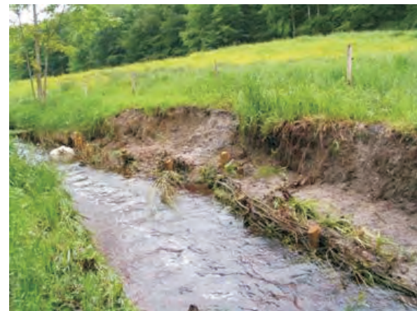
Ufersicherung mit Weidenflechtwerk
