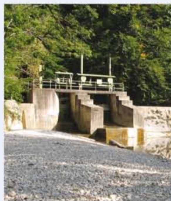
Das über 4 m hohe Beilhackwehr bestand bis 1924 aus Holzbalken. Nach dem Hochwasser 1924 wurde das heutige Betonwehr gebaut.
